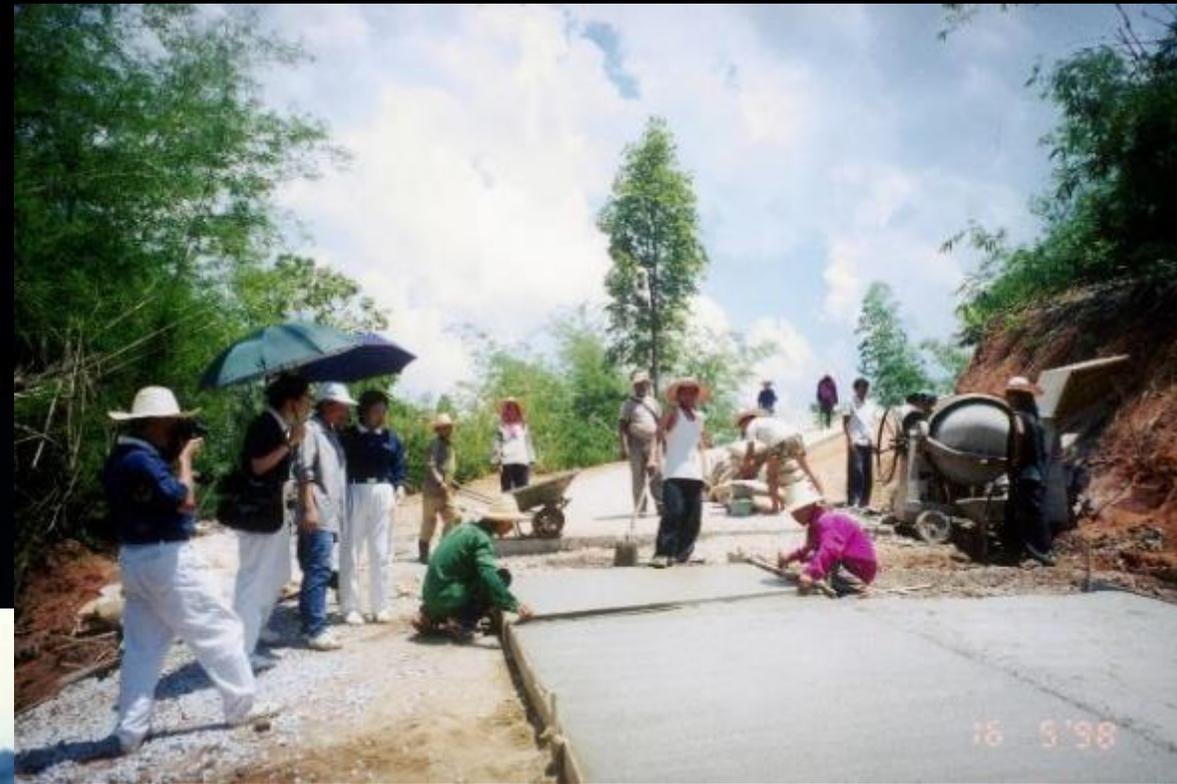
1998年曼谷志工陳世忠，帶著村民砍竹子，把竹節打通釘在山壁上當水管，從山上引水下來，然後剖開竹子充當鋼筋做路基，分六段施工，歷經兩個多月，全長1300公尺的「回賀大愛之路」，終於完工。
